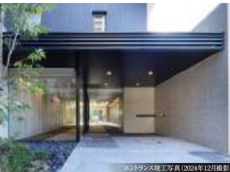
エントランス竣工写真(2024年12月撮影)
