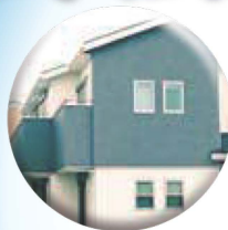
外壁が汚れて見栄えが悪くなってきた
