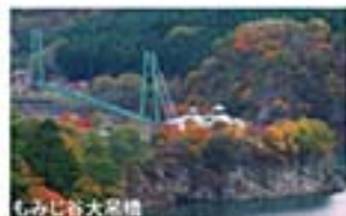
もみじ谷大吊橋
