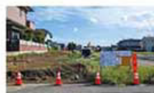
「アリエス・テラス江曾島」現地
